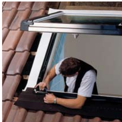
W systemie Roto wymianę przeprowadza się od środka
